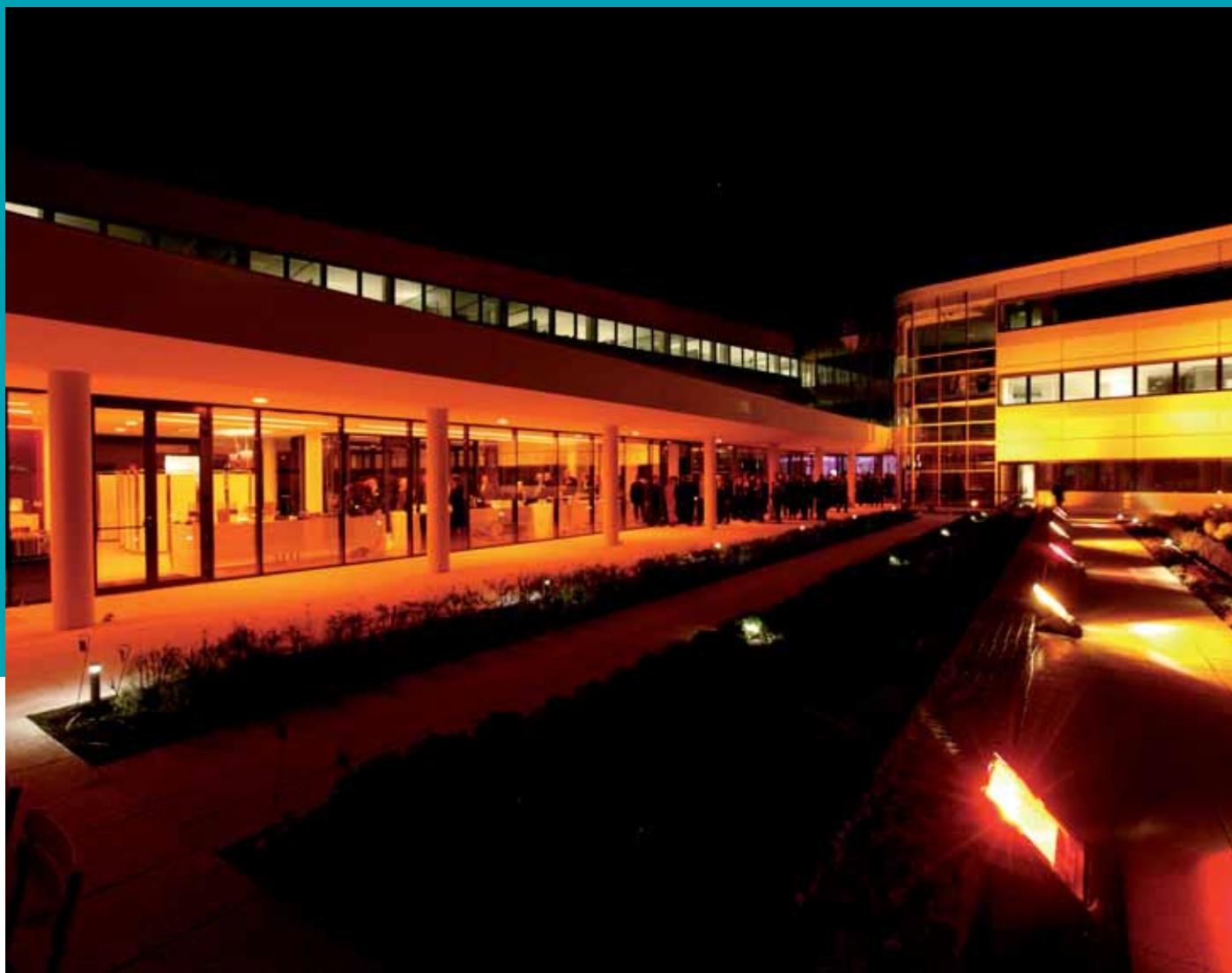
L'accueil de nouvelles entreprises à Guyancourt (ici le siège de Sodexo) atténue les effets de la crise que dans d'autres communes.
